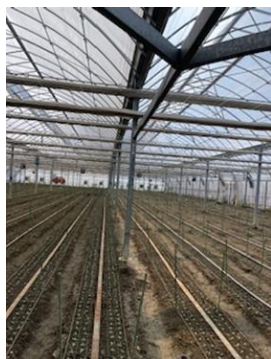
遮熱塗布剤塗布（左側）の様子 (安足農業振興事務所)
