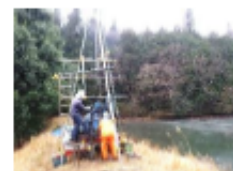
ため池の堤体健全度調査
