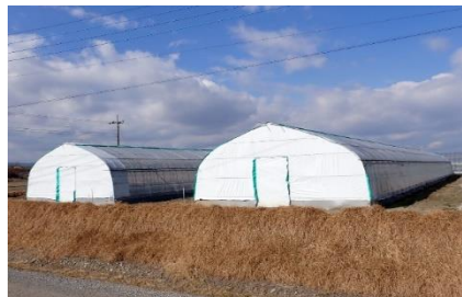
増設したリレー苗育苗ハウス (下都賀農業振興事務所)
