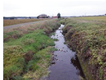
工事前の用水路
