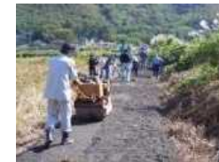
未舗装農道の舗装
