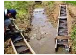
水田魚道の設置
