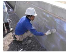
水路壁のコーティング
