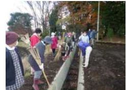
水路の泥上げ
