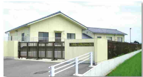
農業集落排水の処理場
