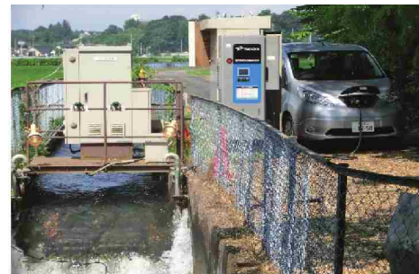
小水力発電実証施設から商用車への充電状況
