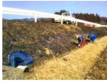
水路の清掃・補修作業 (那須塩原市)
