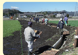
側溝のふたかけ作業
