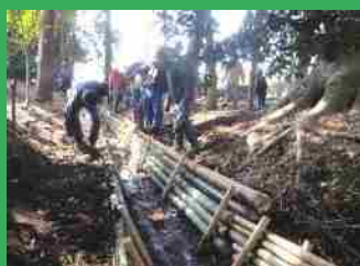
竹柵による土水路の保全
