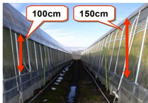
図 17 側窓開口部の拡大
