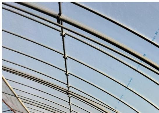
図 29 単管パイプによる補強
