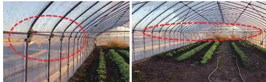
補強する材料と雪の荷重にもよりますが、2m以内の間隔を目安に設置します。
