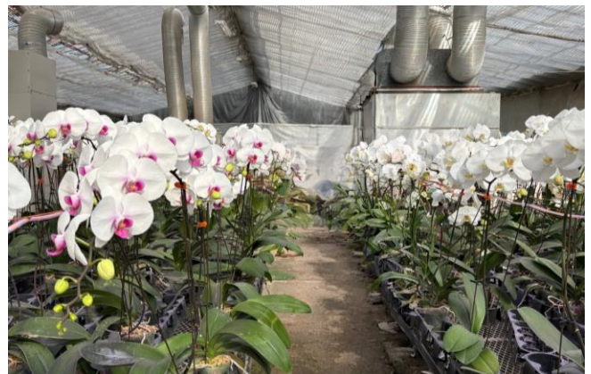
通年でヒートポンプを使用する品目例（洋ラン）
