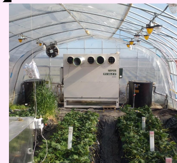
いちご研究所で実証中の地下水ヒートポンプ
