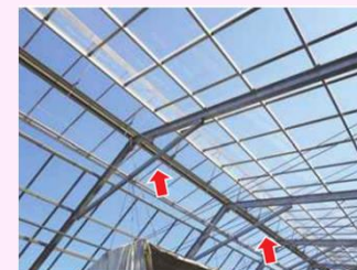
鉄骨ハウスの補強対策
