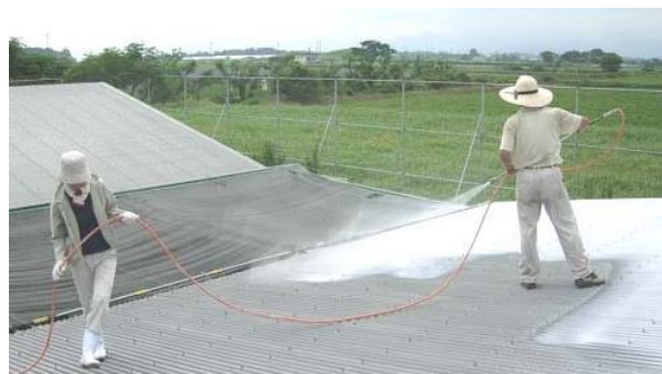
（屋根への石灰吹きつけ）
