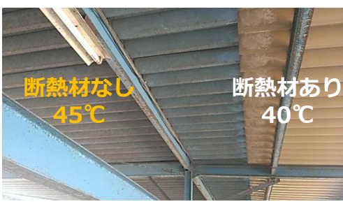
屋根裏断熱材の有無による放射熱の比較
