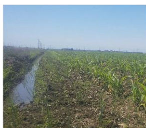
明渠が施工されたほ場
