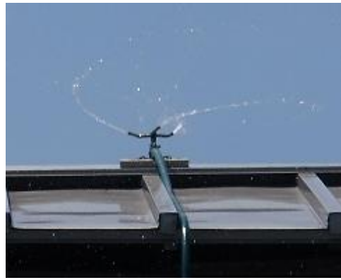
70頭規模フリーストール牛舎で 4台のスプリンクラーを設置した事例
