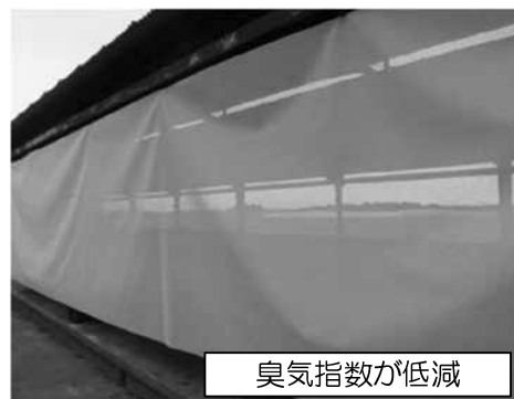
< 発酵施設への防臭カーテン設置 >
