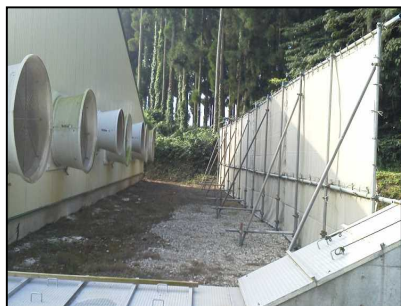
防塵ネット設置
