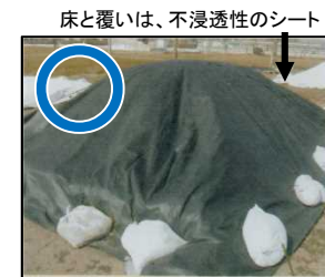
不浸透性シートによる簡易対応
