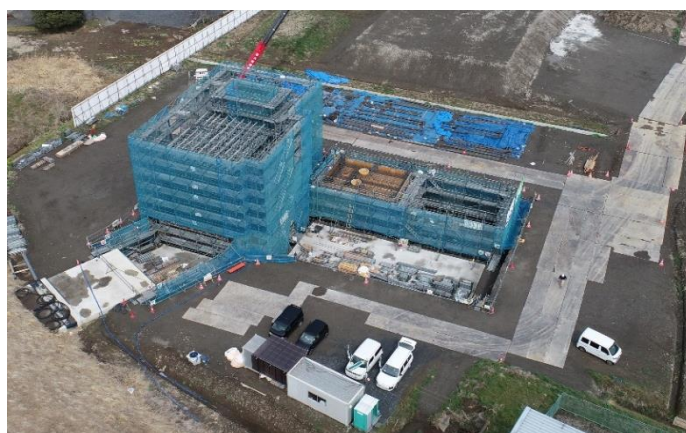
石川排水機場の全景
