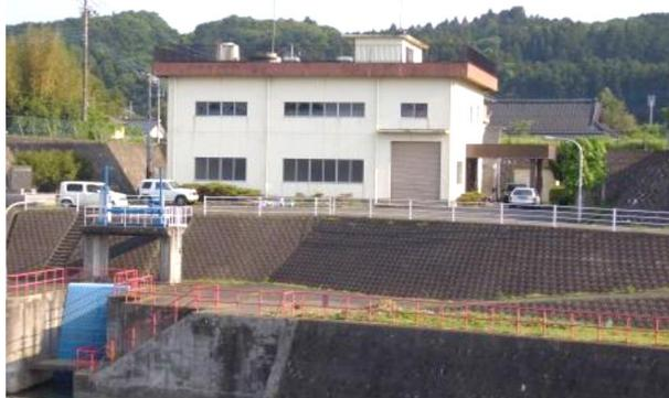
平成4年に造設された本機場は、大田原市を流れる那珂川水系の一级河川箒川からポンプで取水し、大田原市、さくら市、那須烏山市、那珂川町における受益面積1,493ha分の農業用水を担っています。来年度には流量調整に用いる2つのロート弁を修繕予定です。
