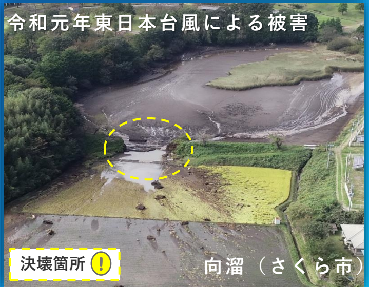
【写真：ため池の堤体が決壊した様子】
