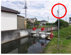
写真 3-3 省力化・監視カメラの設置
