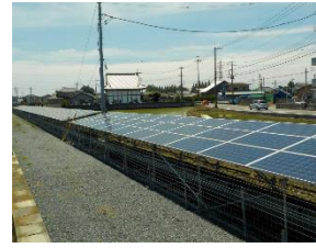
写真 3-4 維持管理費の節減:太陽光パネルの設置
