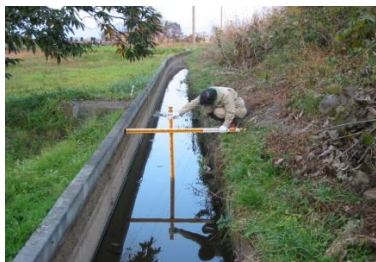
写真 4-1 1次診断 水路の巡回点検
