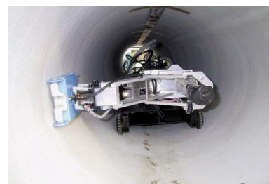
写真 4-3 3次診断 電磁波による管内の詳細調査
