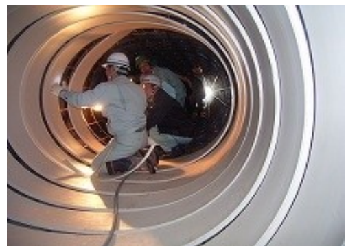
写真2 新技術による補修状況
