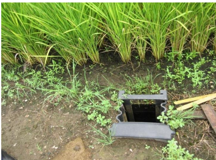
実際に使用されている田んぼダムの排水ます
