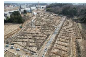
暗渠排水工事
