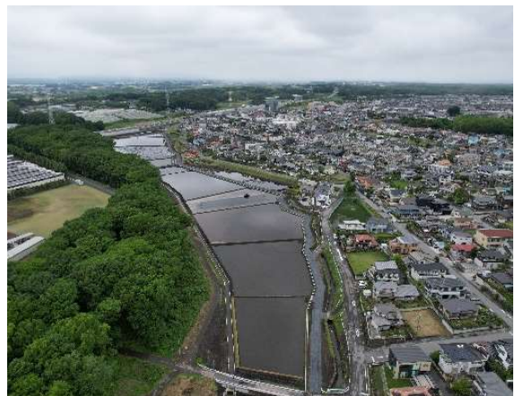
農地整備の施工状況（刈沼川）
