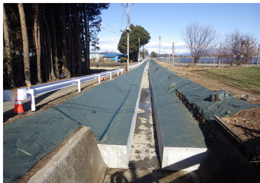
海道地区の水路工事
