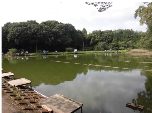
対策工事を待つ初網溜
