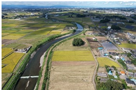
赤沢川 整備予定区域の状況
