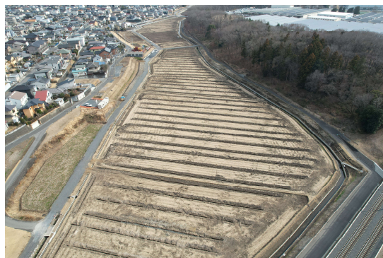
刈沼川地区の暗渠排水工事
