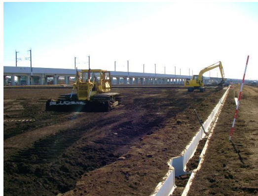
工事真っ盛り
