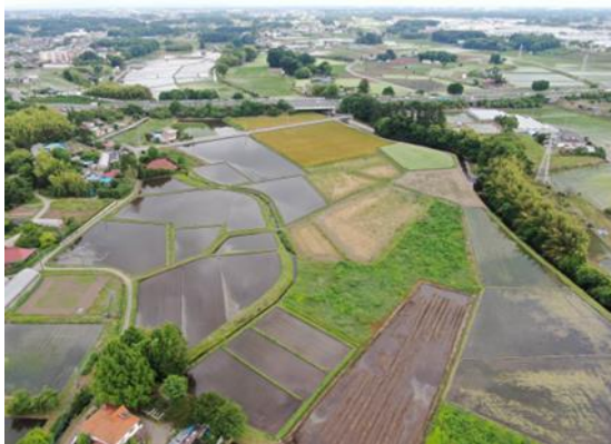
圃場整備工事着手前
