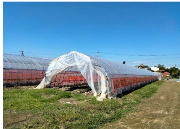
中古施設の資材を活用して 修繕されたハウス
