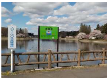
防災重点農業用ため池 唐桶溜(芳賀町)
