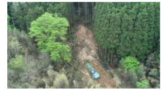
漏水により崩落した山斜面
