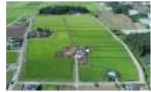
工事が完了した祖母井の農地
