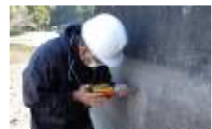
劣化状況等調査
