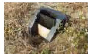
導入された排水柵
