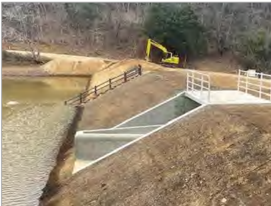
図 63 ため池防災工事現場
