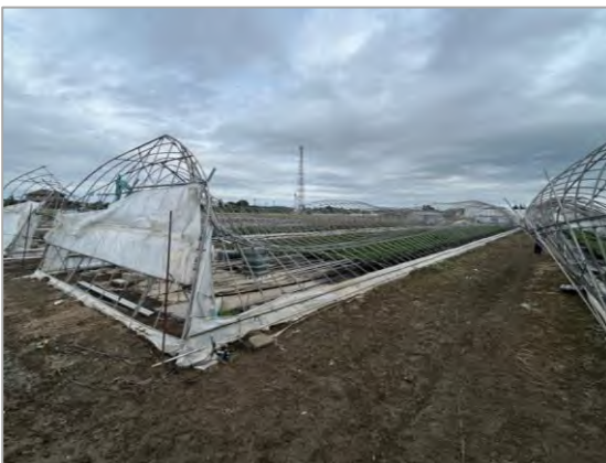
図 59 被害状況①
