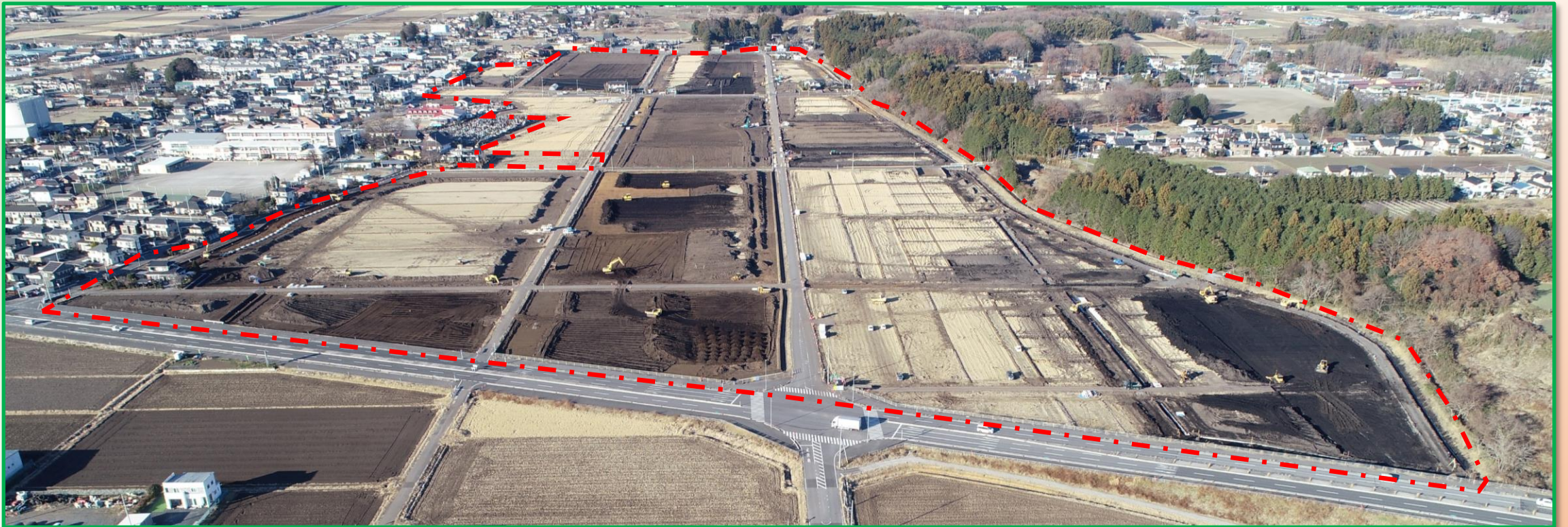
工事が進む祖母井地域の農地
