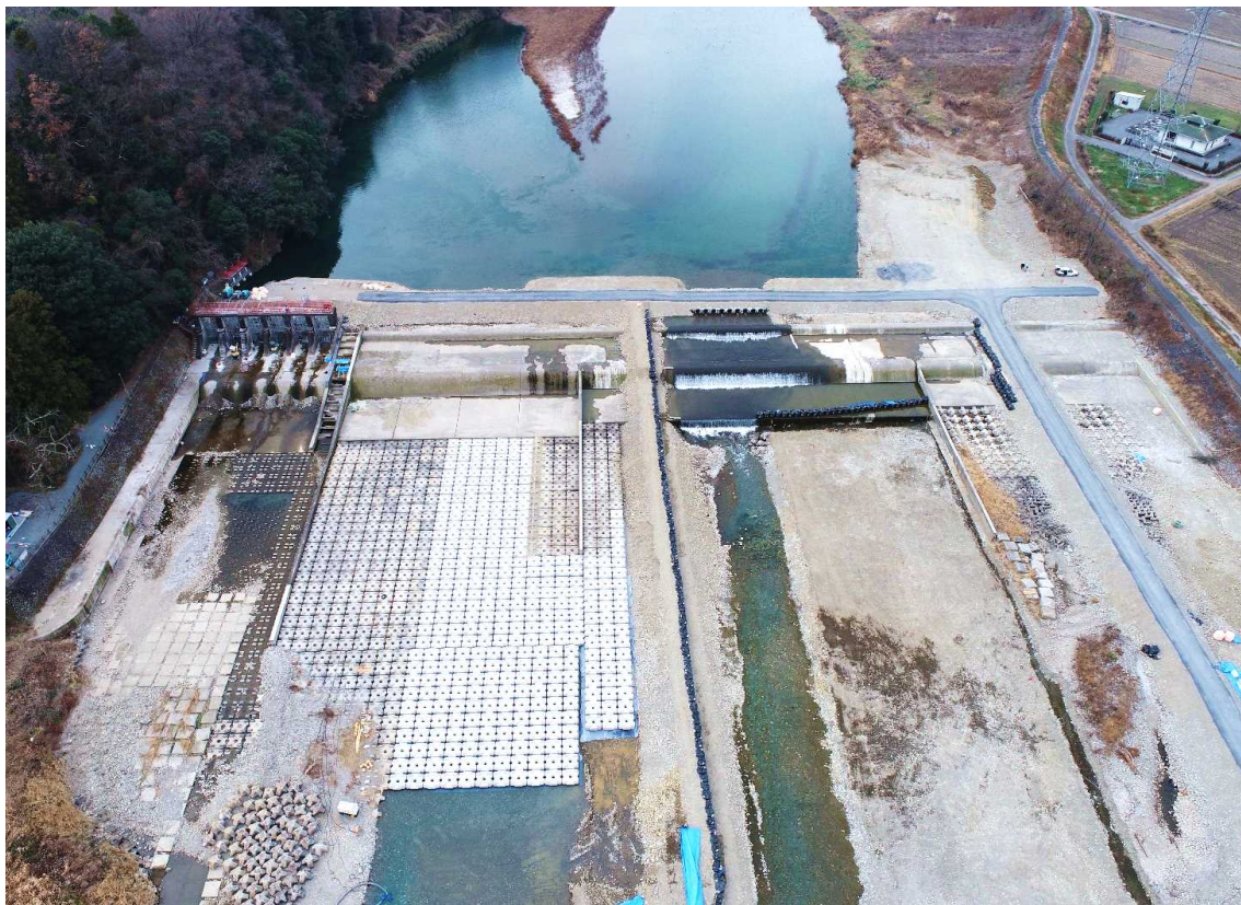
護床工の補修工事「小倉堰」(栃木市)
