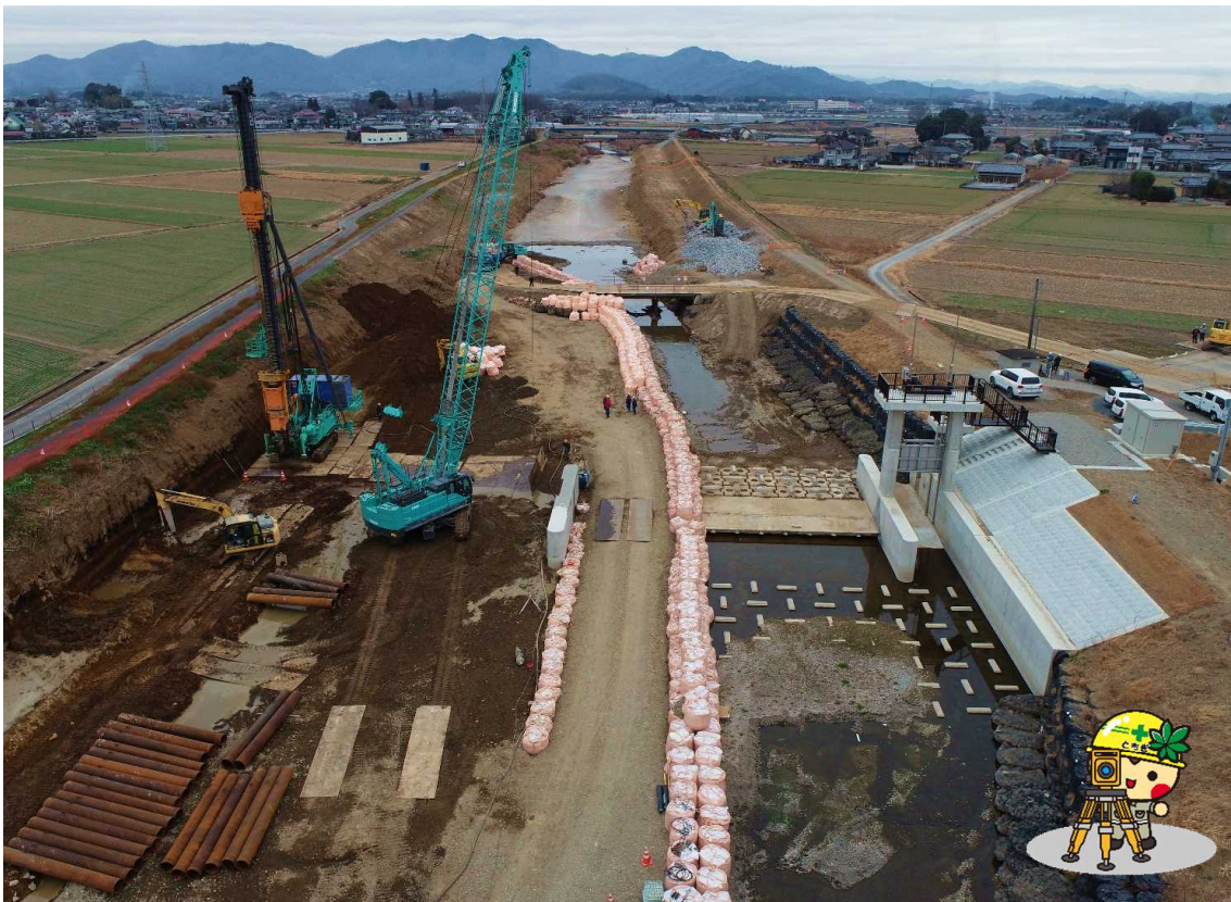
中掘杭工法「押切用水堰地区」(栃木市)
