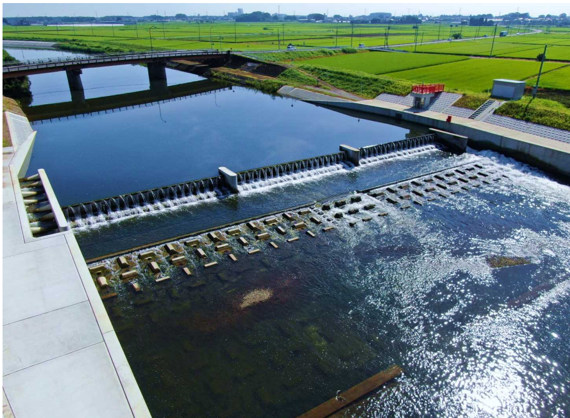
自動転倒堰に生まれ変わった「宮前堰」(下野市)
