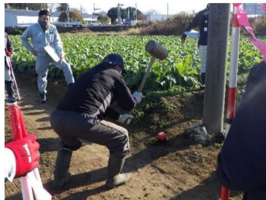
【地区界打設作業（塚崎・田間）】
