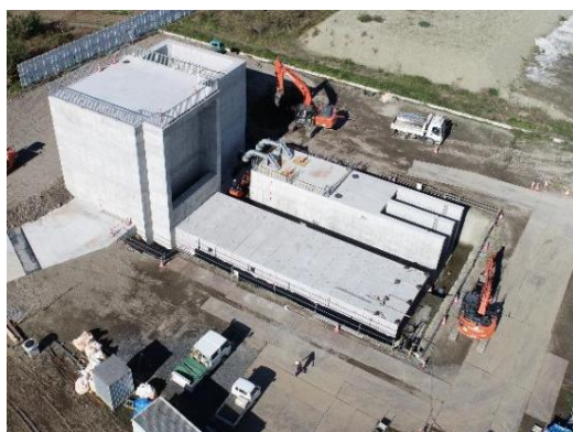
【建設中の排水機場（吸水槽・吐水槽）】
