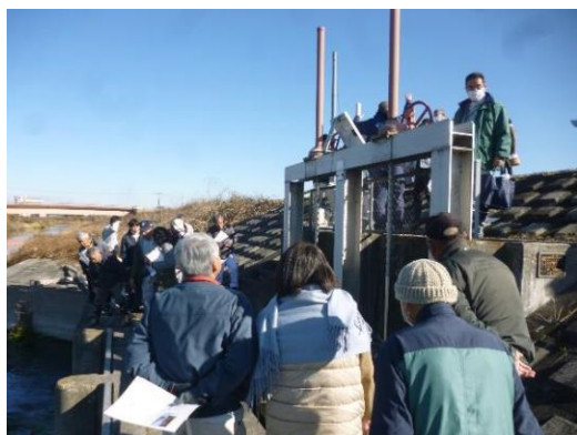
【水門の遠隔操作】
