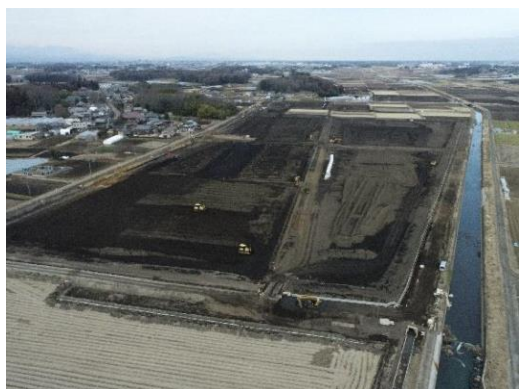
【圃場整備工事の様子】
