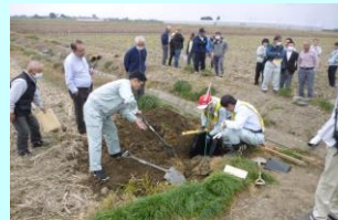
田んぼダム排水マスを設置
