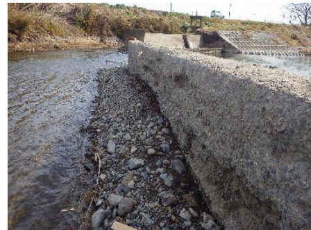
(固定堰に堆積した土砂の様子)
