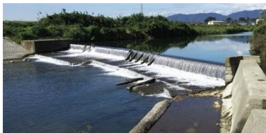
( 押切用水堰の全景 )
