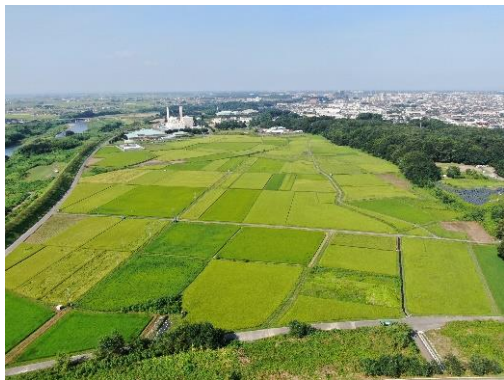
南側から見た様子
