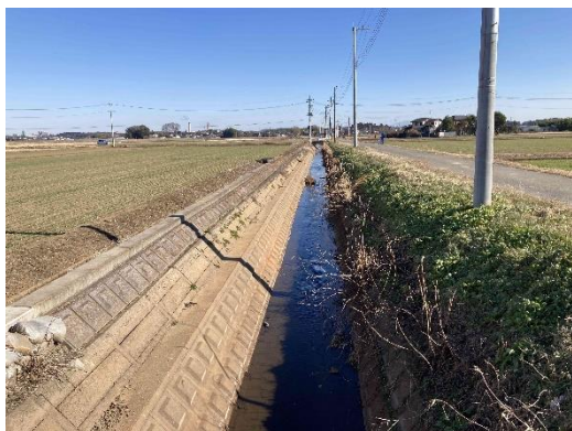
(東清水川排水路)
