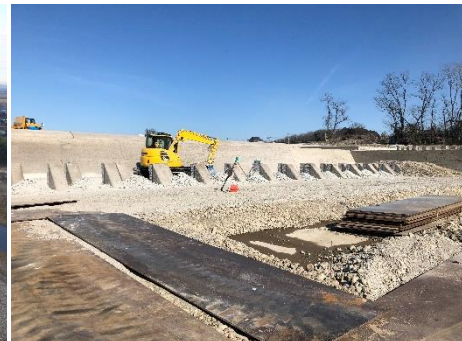
( 水制工の工事の様子 )
