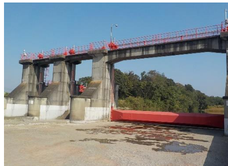
( 改修された洪水吐ゲート )
