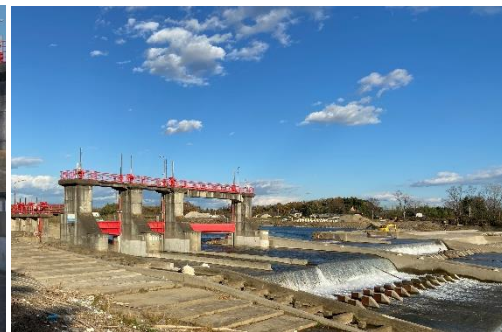
( 完成を迎えた美田東部頭首工 )
