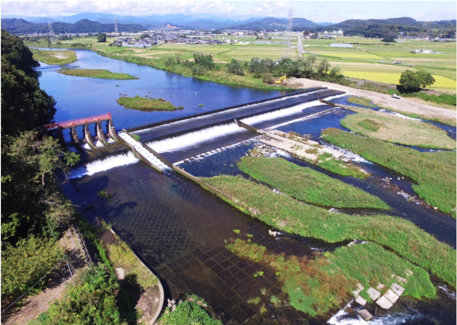
取水期を待つ小倉堰【栃木市】
