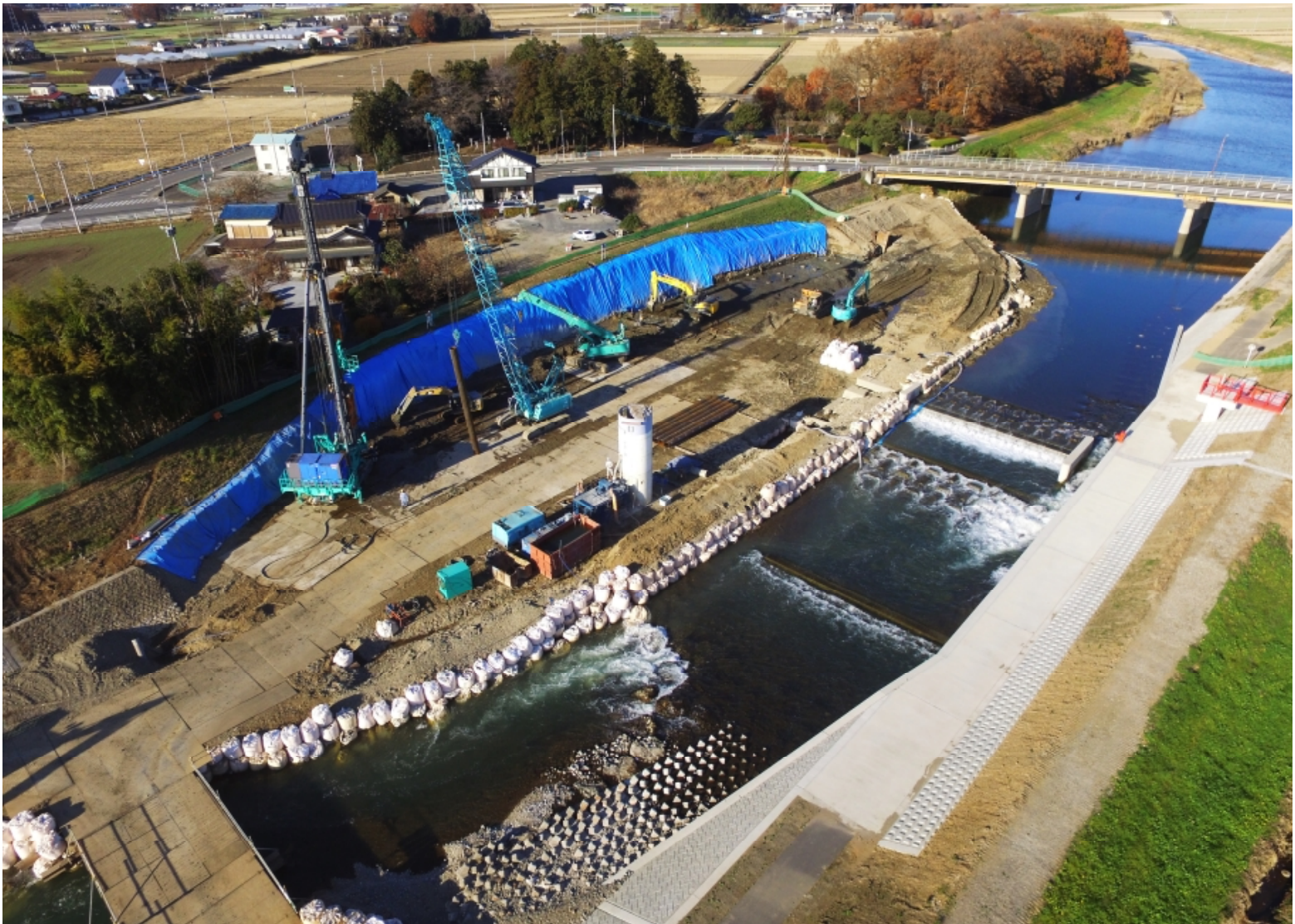
宮前堰 基礎杭打ちの様子(右岸側)【下野市】
