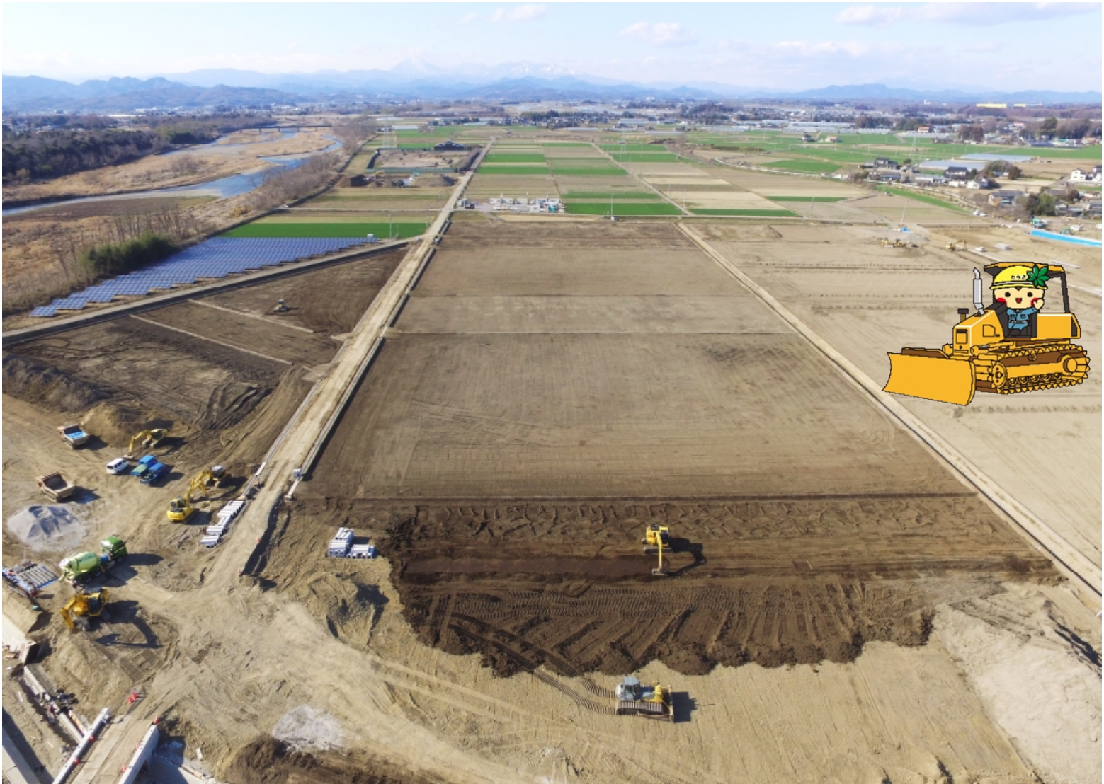
ほ場整備工事を進める下稲葉地区(壬生町)
