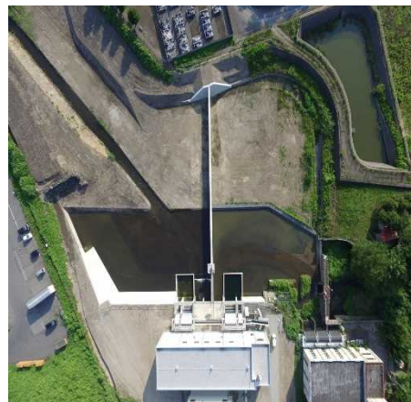
（ 遊水池工事後 ）
