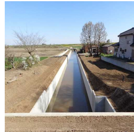
（ 排水路工事後 ）
