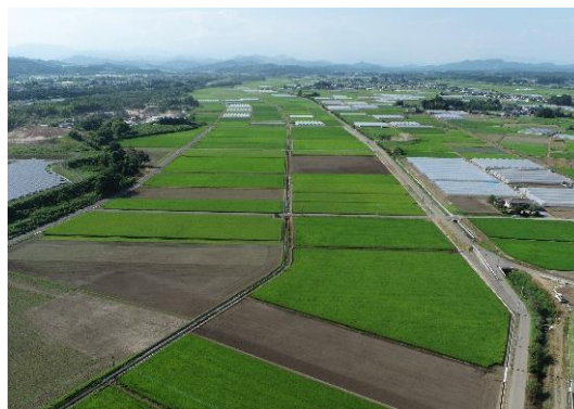
( 工事後の様子 )
