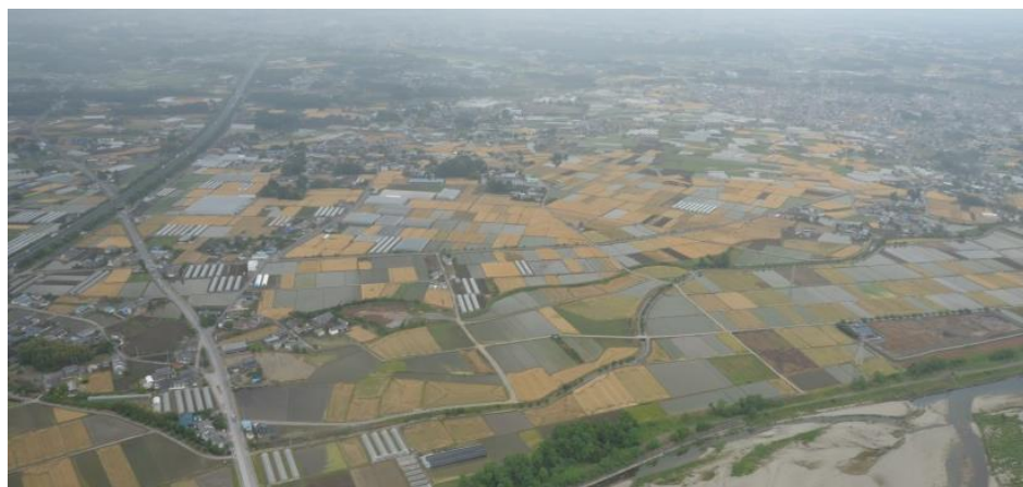
( 工事着手前・下稲葉地区の全景 )
