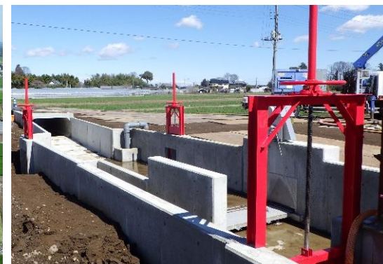
( 完成した分水工 )
