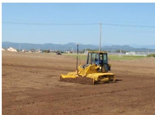
( ICT建機を使用した整地作業 )
