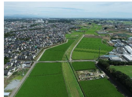
( 施工後ほ場の様子 )
