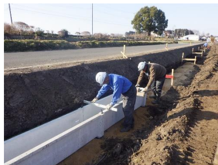
( 用水路を据え付ける様子 )
