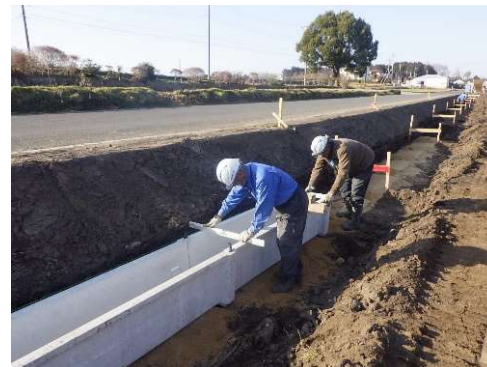
( 用水路を据え付ける様子 )
