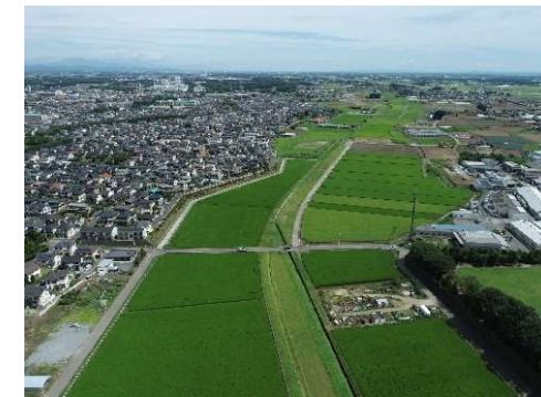
( 施工後ほ場の様子 )
