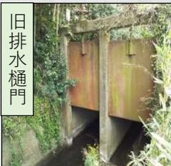
そこで、2018年～2021年にかけて旧排水樋門を廃止し、自動ポンプゲートを新設しました。このポンプゲートは永野川の水位上昇を検知すると自動でゲートが閉まり、ゲート付属のポンプで排水路の内水を永野川に排水します。また、タブレットにより維持管理ができるようになりました。このことにより、維持管理の省力化と農地の湛水防止につながりました。
