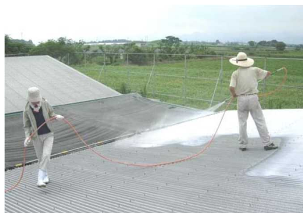
(屋根への石灰吹きつけ)
