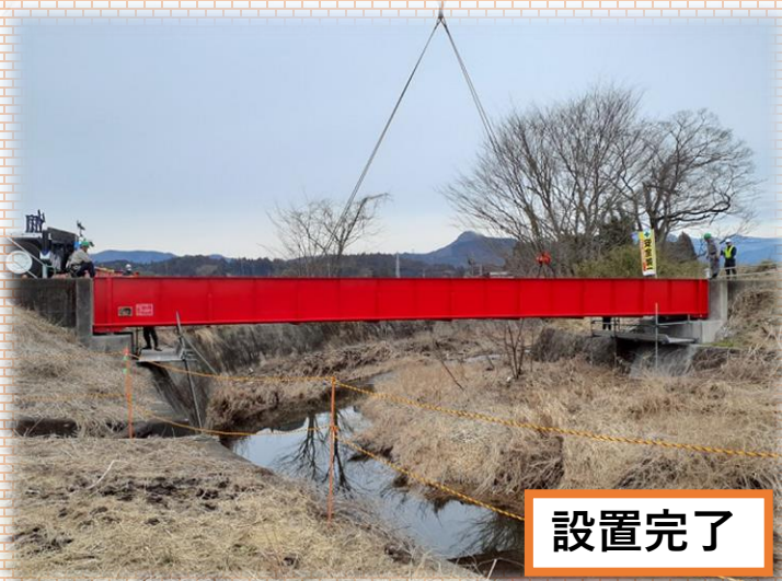
クレーンによる架設
