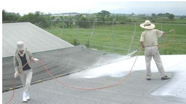
(屋根への石灰吹きつけ)
